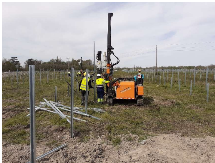
Exemple d'enfoncement de pieux – Source : TotalEnergies
