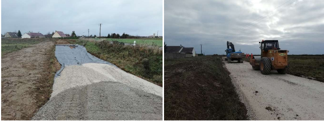
Vues sur des pistes en construction – Source TotalEnergies
